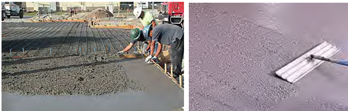
Fig. 2.36. a. Përpunimi përfundimtar i betonit me vegla të dorës
