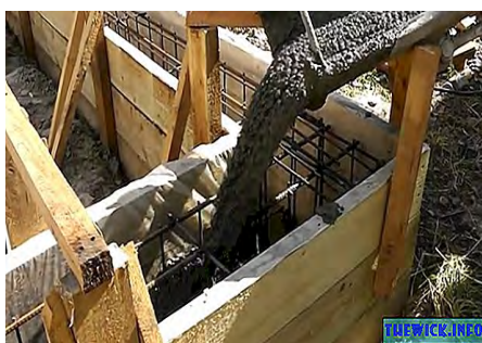
a. Betonimi i mureve me hedhje të betonit nga lart
