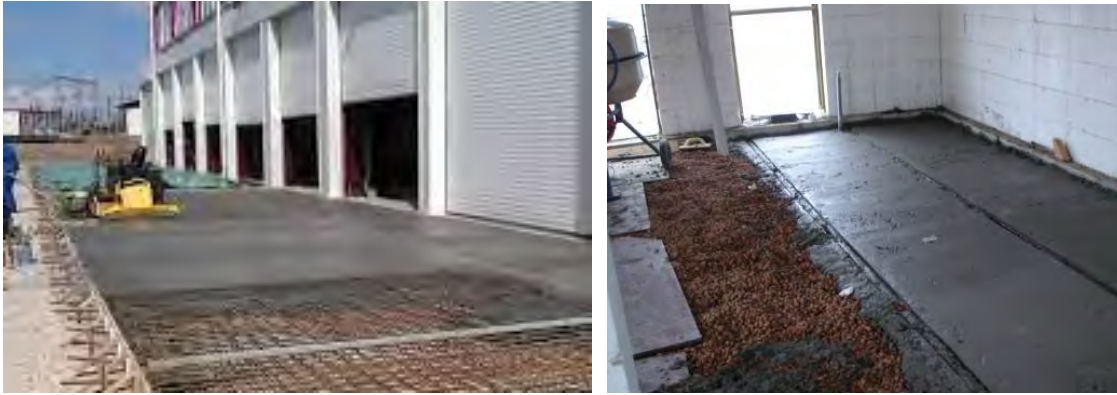
Fig. 2.29. Betonimi i dyshemeve, platformave dhe ngjashme me ato
