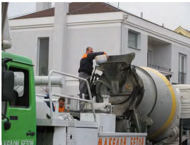
Fig. 1.30. Shtimi i aditivëve në masën e betonit menjëherë para betonimit
