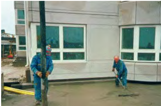
Fig. 3.14. Vendosja e betonit të lehtë
