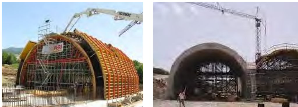
Fig. 2.28. Betonimi harqeve dhe qemerëve
